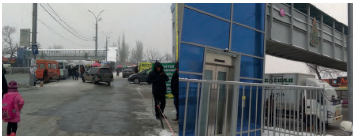
Сүрөт 2.2.1. Бишкек шаарынын Аламүдүн базары тараптагы жол үстүндөгү өтмөк (2018 жыл). Лифт иштебей кулпулангандыктан, улгайган адамдар тепкичтен өйдө көтөрүлө албай кыйналышат
