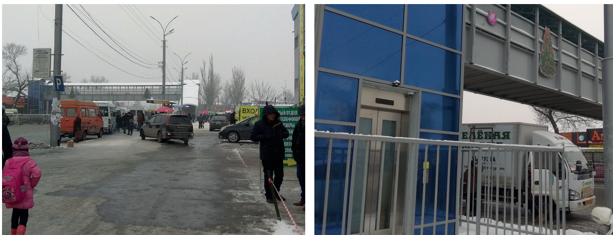
Фото 2.2.1. Надземный переход в Бишкеке, в районе Аламединского рынка (2018 год). Пожилым людям сложно преодолевать подъем по лестнице, лифт находится в нерабочем состоянии и заперт на замок.
